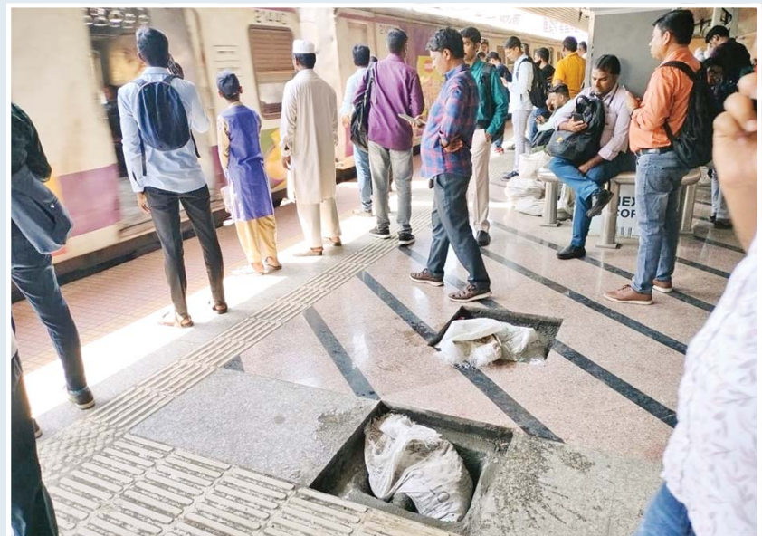
સુરક્ષાનો અભાવ... વડાલા સ્ટેશન પર હાલમાં સમારકામ ચાલી રહ્યું છે, પરંતુ આ કામ દરમિયાન સુરક્ષાની કોઈ જોગવાઈ રાખવામાં આવી નથી. તસવીરમાં પ્લેટફોર્મ પર લાદી બેસાડતી વખતે ખાડાની આજુબાજુ કોઈ સુરક્ષા વ્યવસ્થા રાખવામાં આવી નથી જેથી ભીડના સમયે કોઈ પણ પ્રવાસી તેમાં પડીને જખમી થઈ શકે છે. (અમથ ખરાડે)
