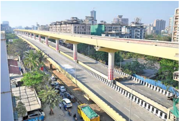
ડબલ ડેકર ફ્લાયઓવરની કુલ લંબાઈ ૮૫૦ મીટર છે. મેટ્રો અને ફ્લાયઓવરના થાંભલા ૨૧ છે. મેટ્રો લાઈન નવના વાયાડક્ટ જે થાંભલા પર ઉભા કરવામાં આવ્યા છે તે જ થાંભલા પર પુલ બનાવવામાં આવ્યો છે. તેથી જગ્યા અને સંરચનાત્મક કાર્યક્ષમતાનો કમાલનો ઉપયોગ કરવામાં આવ્યો છે.
